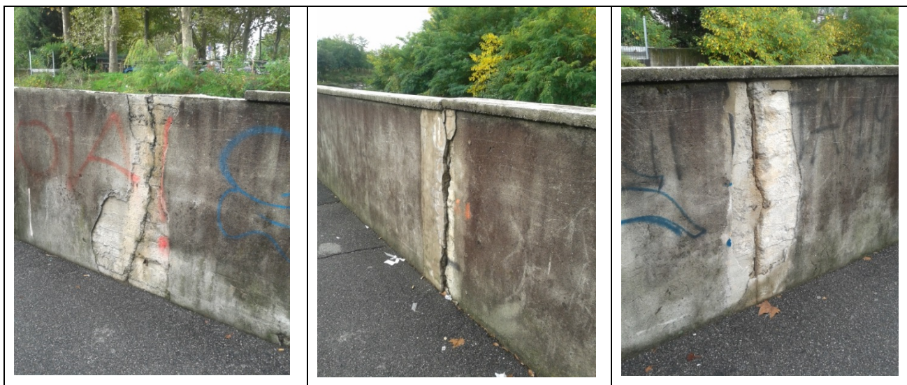
Figura 26 – Vista delle crepe presenti lungo il muro spondale di Via Ghilini
