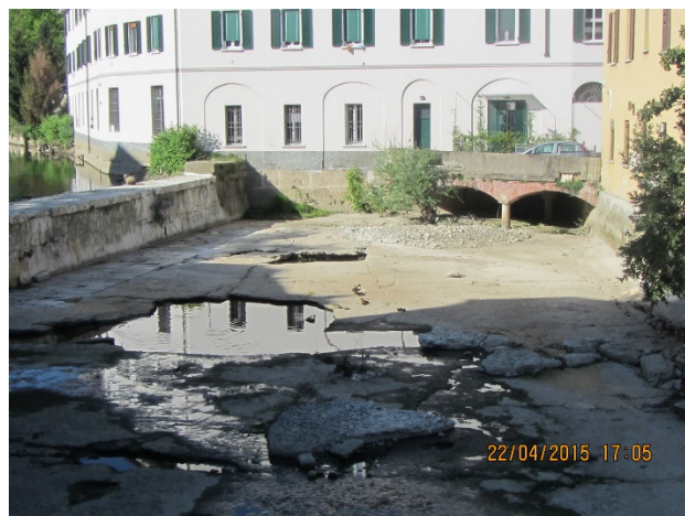
Figura 23b - Vista dal ponte di Via De Amicis della traversa di San Gerardino e dell'alveo del Lambro ammalorato
