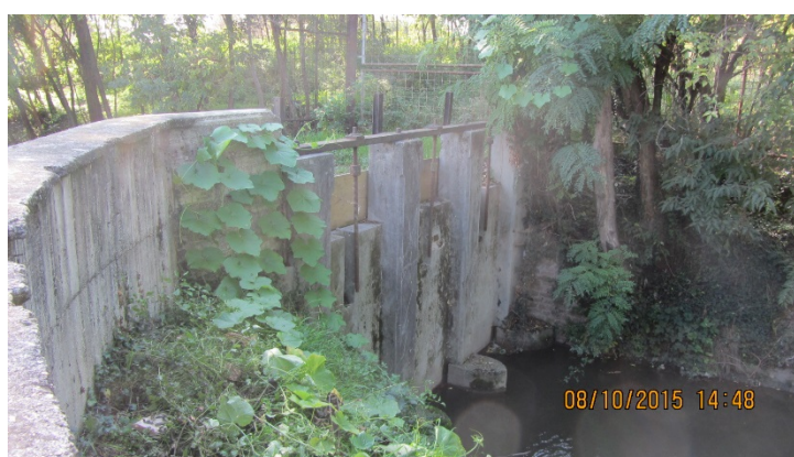
Figura 28 - Vista del manufatto di regolazione sulla Roggia Lupa dal lato interno dal quale si nota l'assenza delle paratoie
