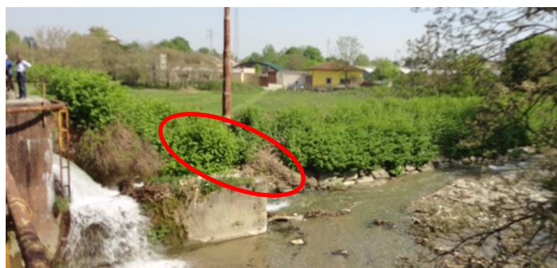
Figura 29 – Vista della falla arginale lungo la sponda sinistra a valle del Pontecanale Villoresi
